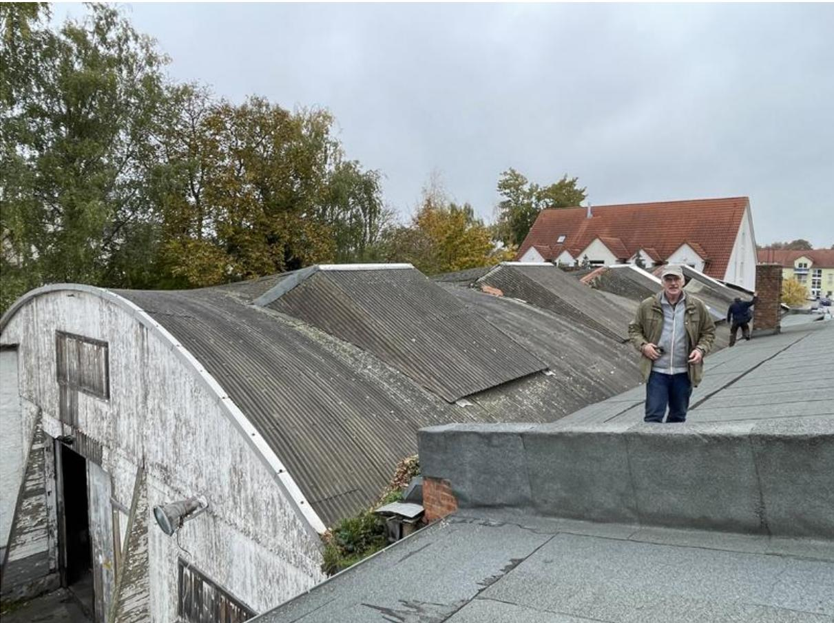
**Abb. 6** Hallendach mit später installierten Lichtöffnungen bei einer Begehung in 2023.
