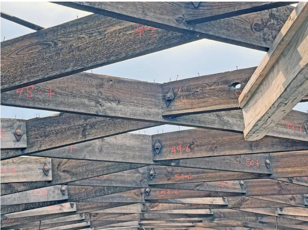
**Abb. 15.** Nummerierung der rund 1.000 miteinander verschraubten Dachlamellen.
