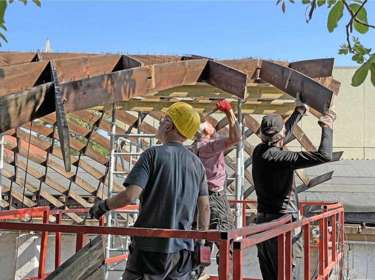
**Abb. 16** Demontage des Holzlamellendaches von Hand
