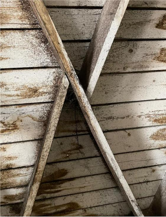
**Abb. 9** Sogenannte K-Strebe aus rechts- und linksgeschmiegen Lamellen.
