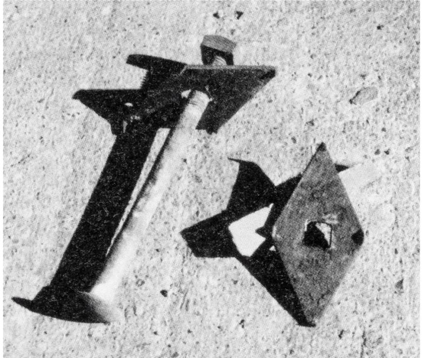
**Abb. 10** standardisierte Schraubbefestigung einer „K-Strebe“. Ca. 900 davon müssen an Ort und Stelle demontiert werden.
